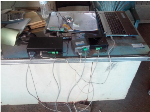
圖 4.1 現場設備安裝畫面
