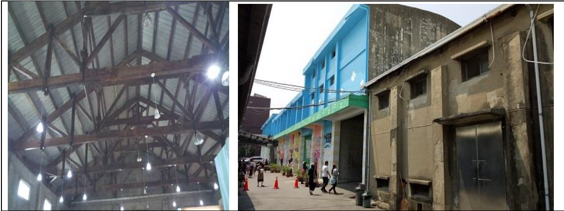
舊穀倉的建築架構可見其歷史風貌
