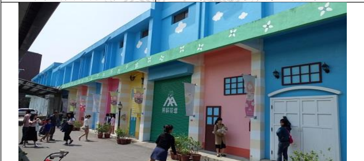
閒置穀倉外牆歐風活潑鮮明，館內外為氛圍舒適
