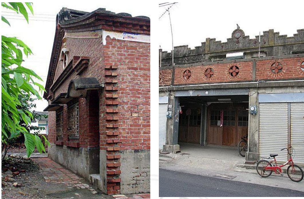
圖 4.13 過溝現存紅磚三合院、洋樓之一
