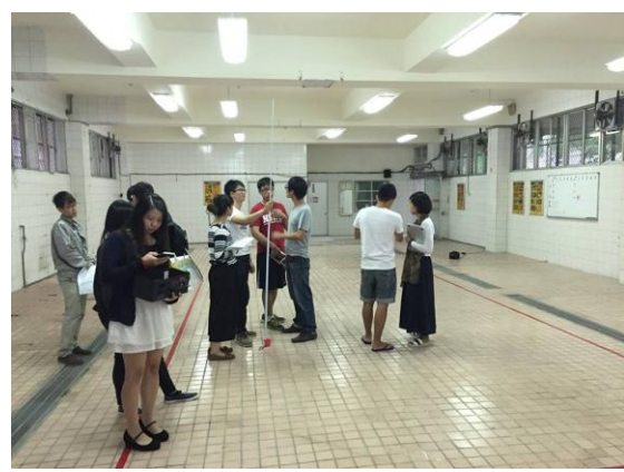
舊廚房廚具淨空，進行改建中
