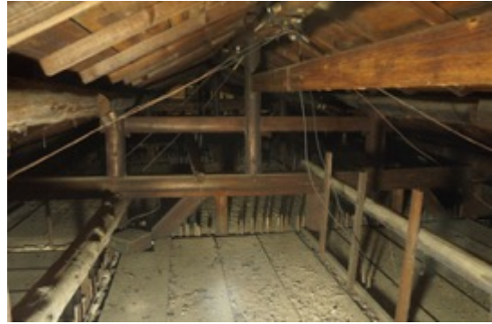
圖2-2-9 Y5 屋架現況照片
