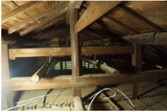
圖2-2-8 Y3 屋架現況照片
