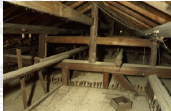
圖2-2-13 Y7 屋架現況照片
