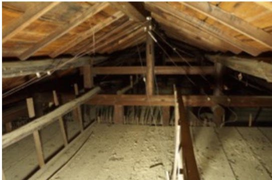
圖2-2-10 Y5 屋架現況照片
