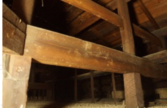
圖2-2-11 Y6 屋架現況照片
