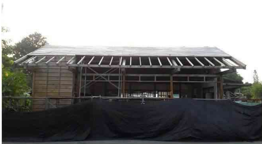
圖 4-58 屋面板完工 資料來源：研究自行拍攝
