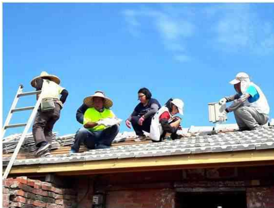
圖 4-29 屋瓦施工 資料來源：研究自行拍攝
