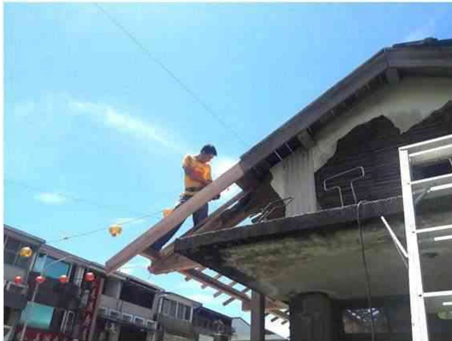
圖 4-55 破風板施工 資料來源：研究自行拍攝
