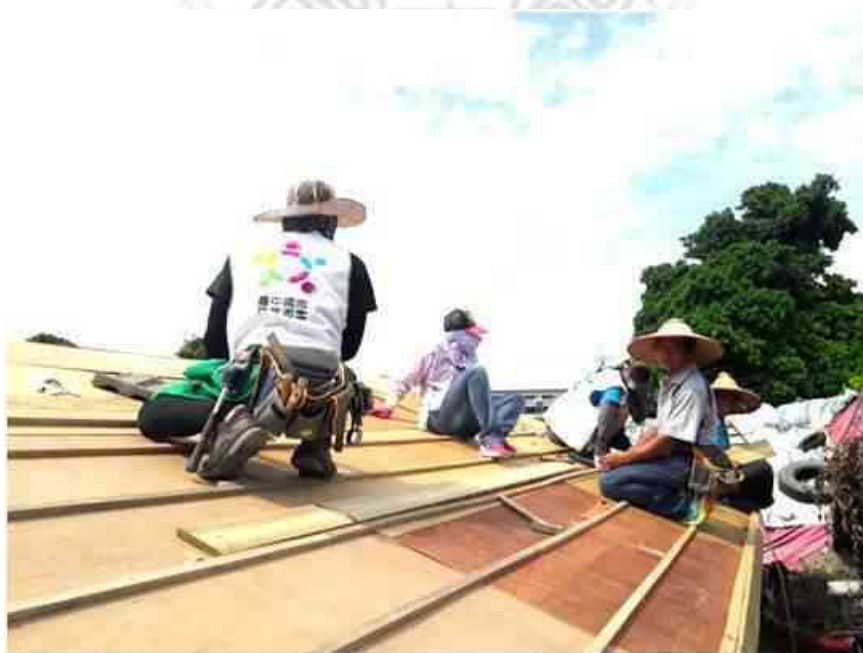
圖 4-28 壓條施工 資料來源：研究自行拍攝
