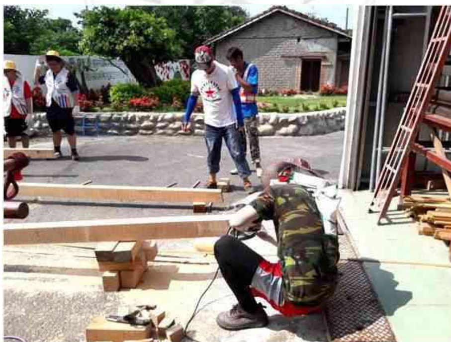
圖 4-18 木料照現場尺寸修改長度-2 資料來源：研究自行拍攝
