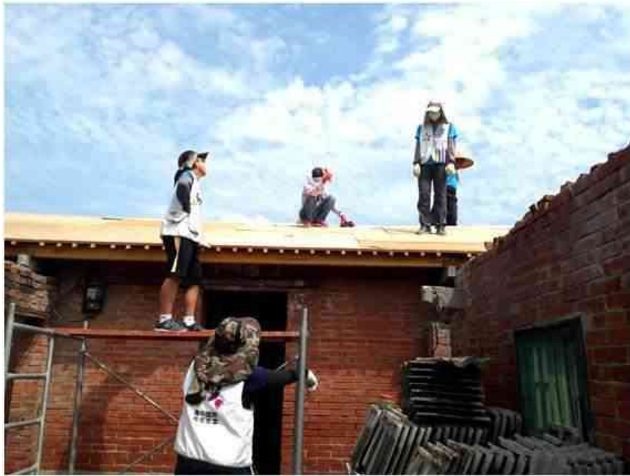
圖 4-27 屋面板施工 資料來源：研究自行拍攝
