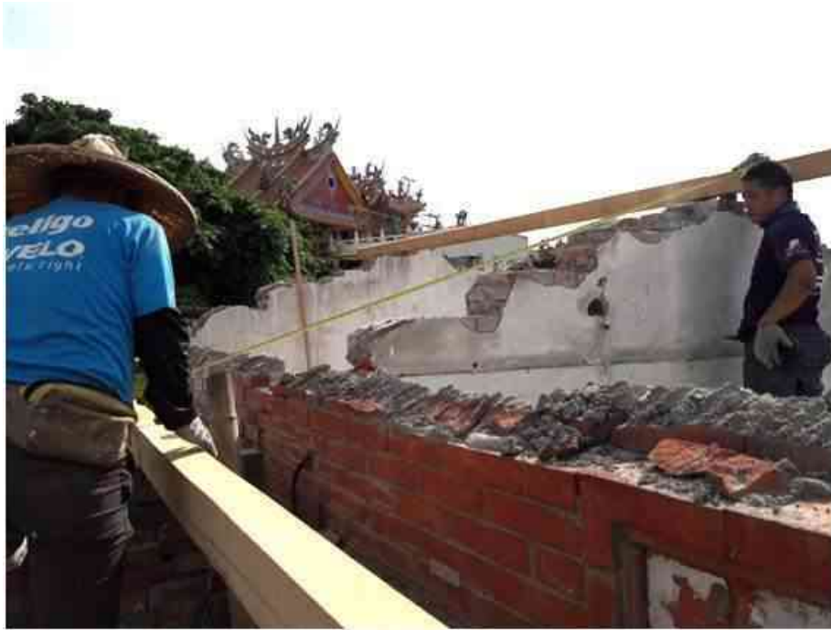
圖 4-19 主樑施工-1 資料來源：研究自行拍攝
