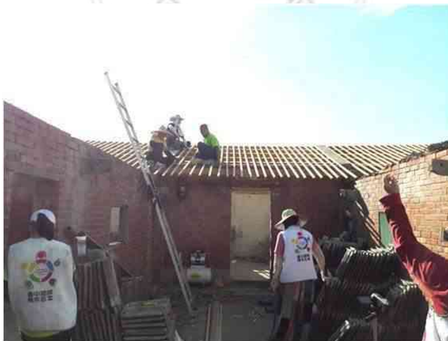
圖 4-22 角料施工 資料來源：研究自行拍攝
