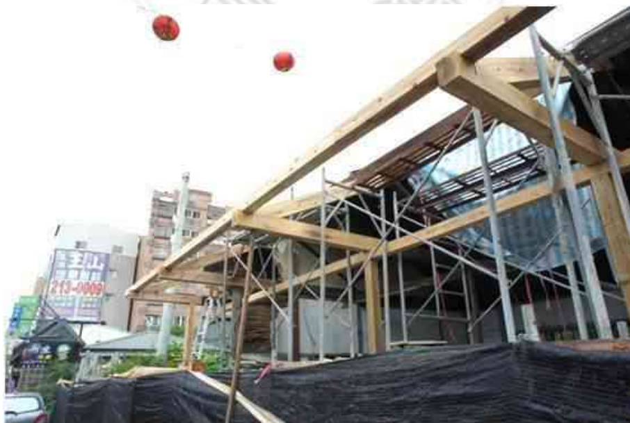
圖 4-50 軒桁施工 資料來源：研究自行拍攝
