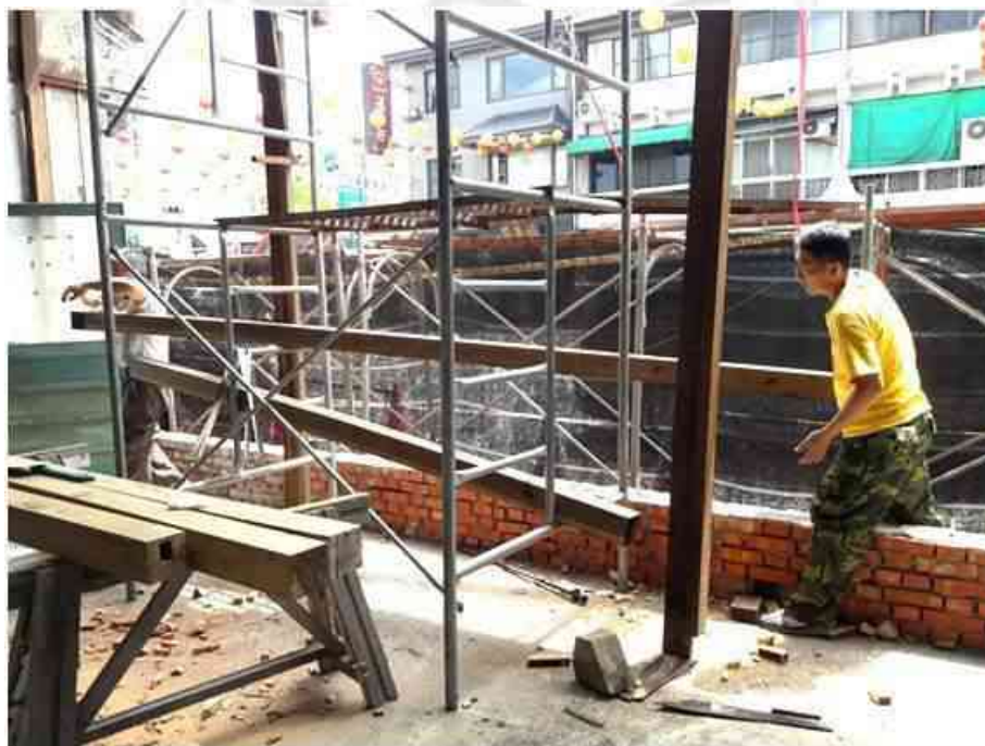
圖 4-48 土台施工-2 資料來源：研究自行拍攝
