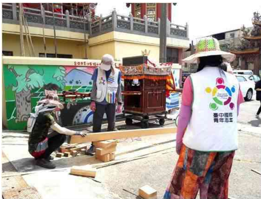
圖 4-17 木料照現場尺寸修改長度-1 資料來源：研究自行拍攝
