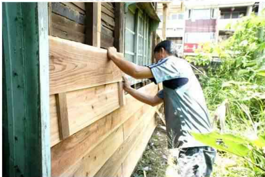
圖 4-56 雨淋板施工 資料來源：研究自行拍攝
