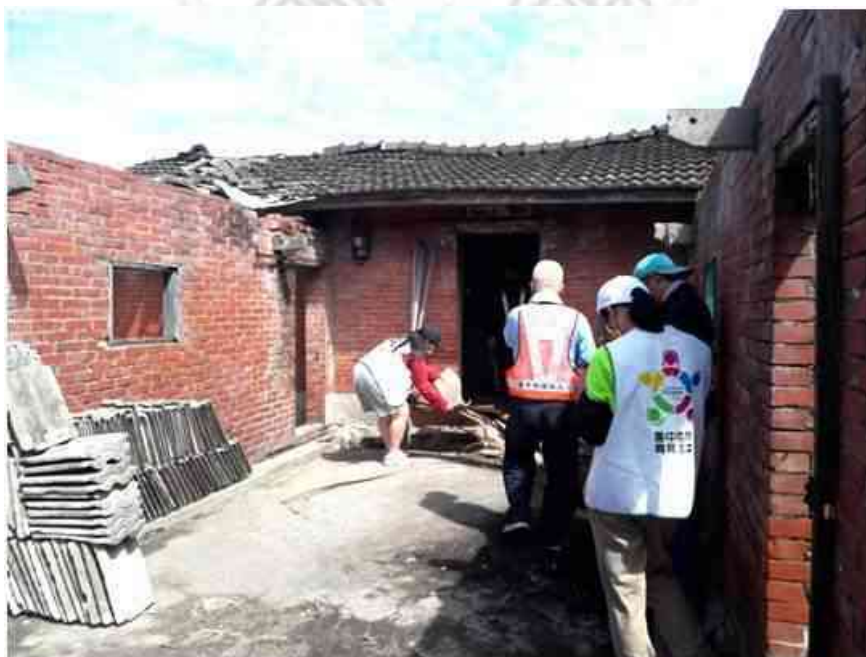
圖 4-16 移除毀損屋架 資料來源：研究自行拍攝
