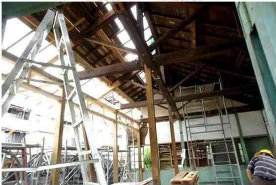
圖 4-52 屋面板施工 資料來源：研究自行拍攝
