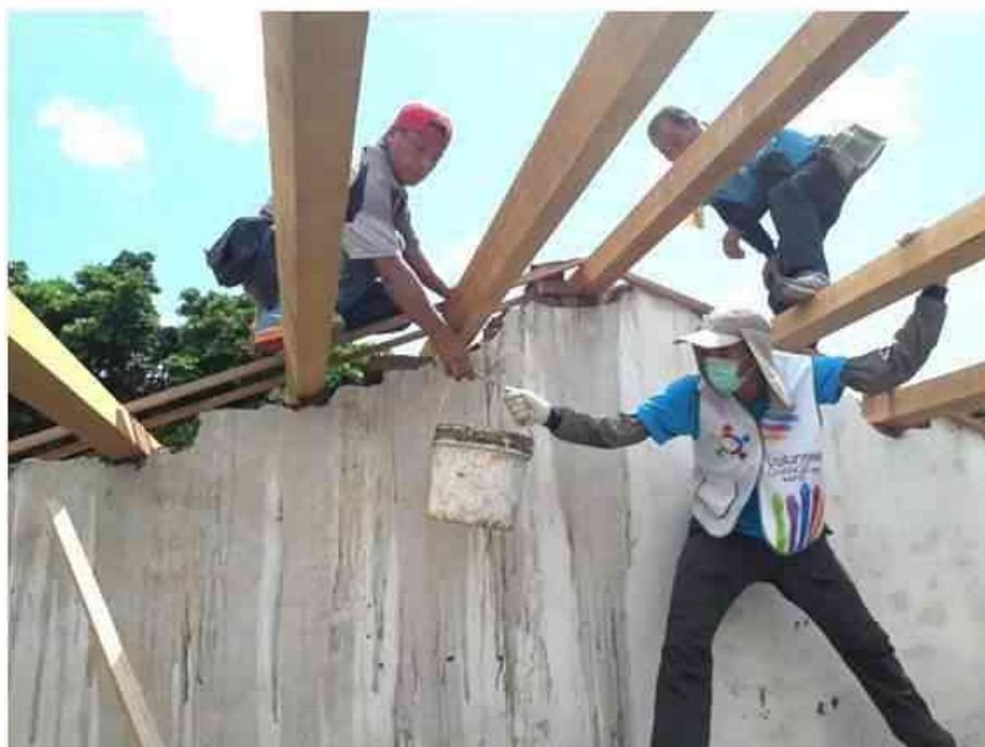
圖 4-21 補強施工 資料來源：研究自行拍攝
