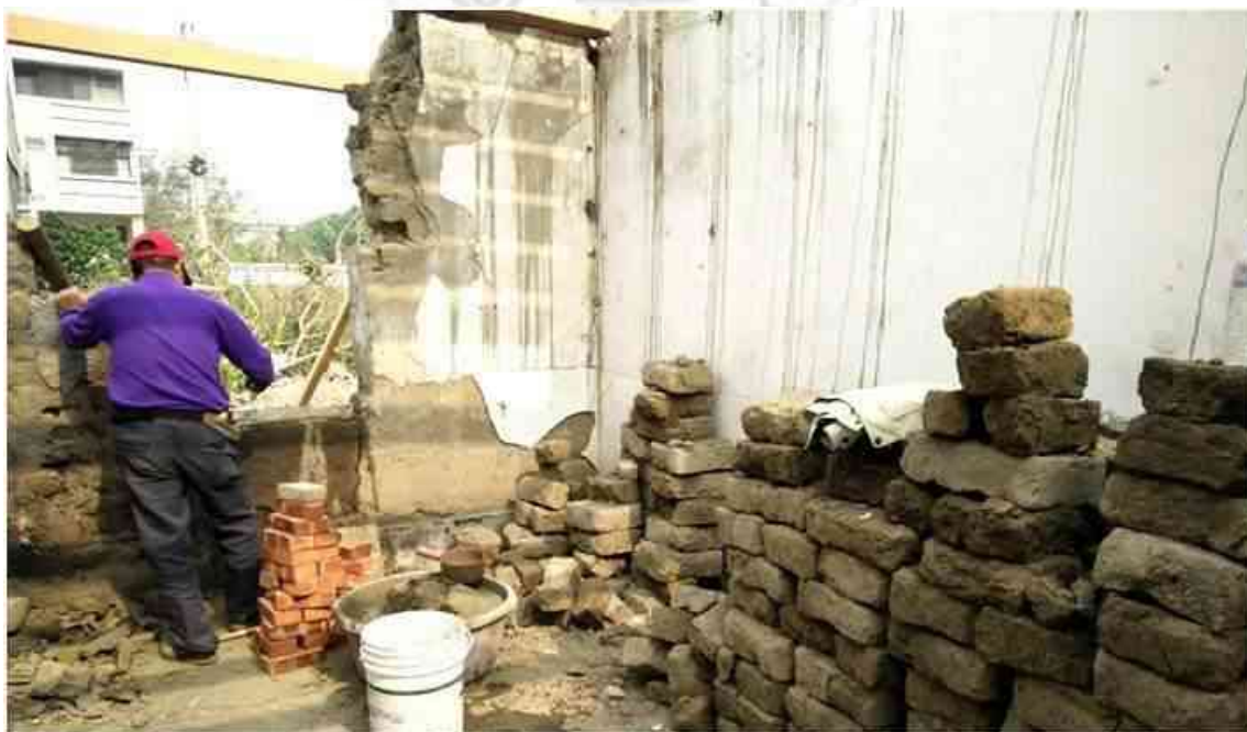
圖 4-5 第一棟土埆厝補強土埆牆面及木窗施工 資料來源：蔡佳君小姐提供
