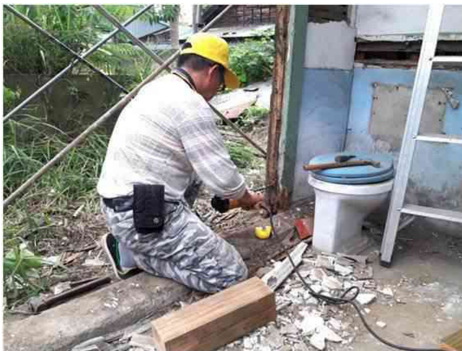
圖 4-47 土台施工-1 資料來源：研究自行拍攝
