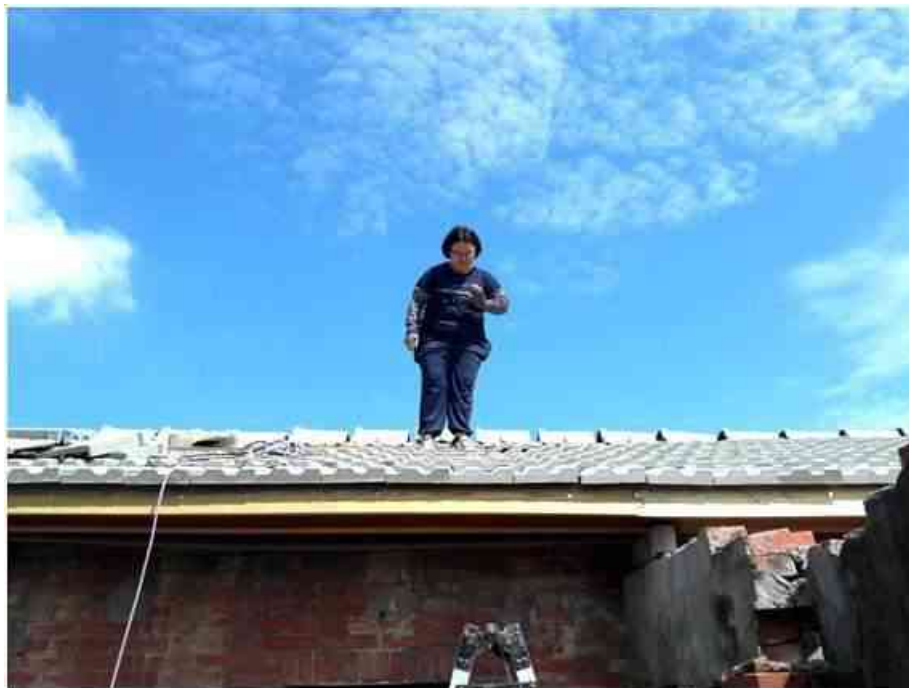
圖 4-31 屋瓦施工-1 資料來源：研究自行拍攝
