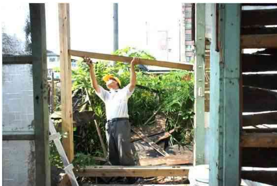
圖 4-53 窗框施工-1 資料來源：研究自行拍攝
