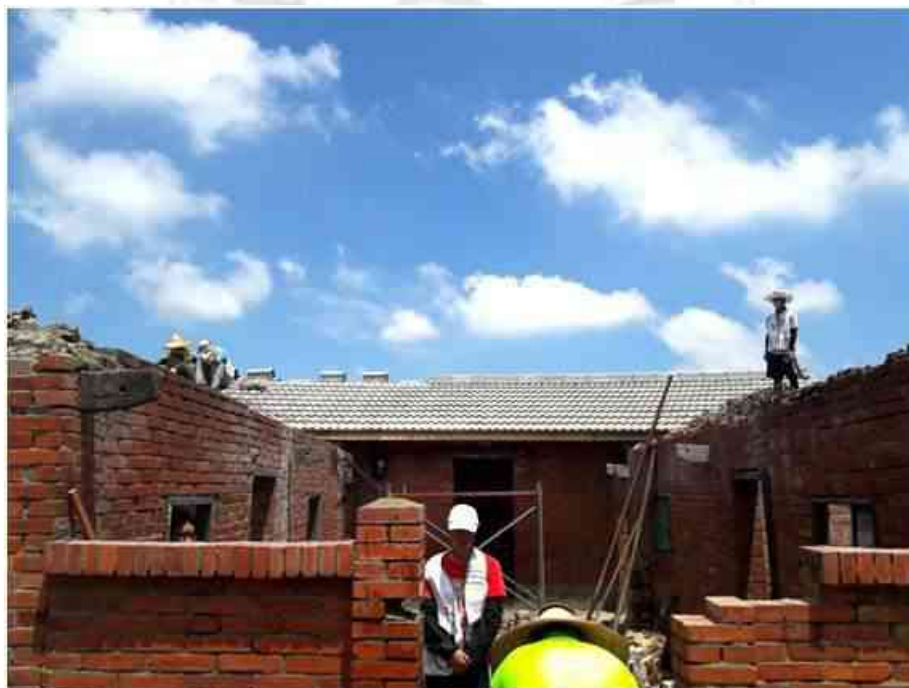
圖 4-32 屋瓦施工-2 資料來源：研究自行拍攝
