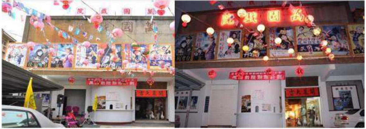
圖 2-14 萬國戲院門面修復完工
