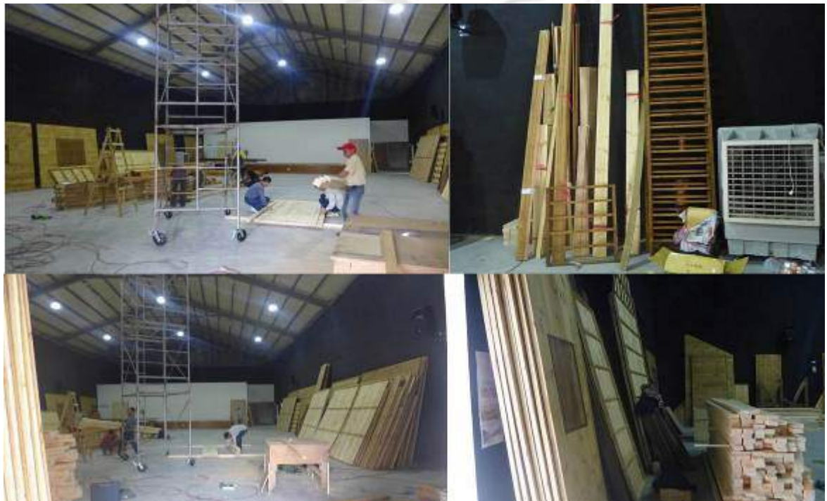
圖 4-5 民視搭設戲院場景施工過程-1 資料來源 本研究拍攝
