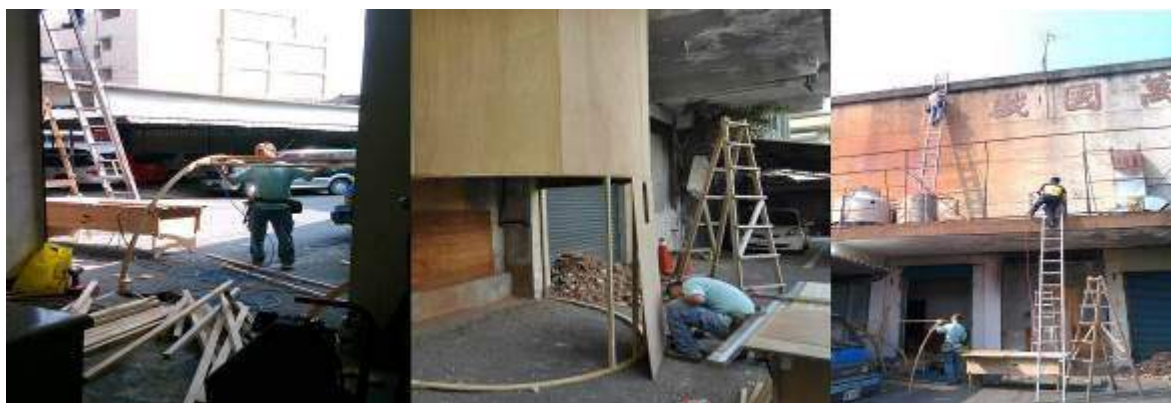
圖 2-11 萬國戲院外觀工程修復
