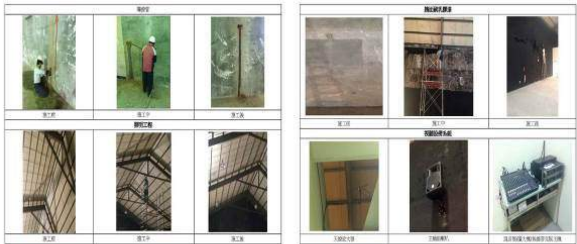
圖 3-13 萬國戲院空間水電音響設施工程 資料來源 本研究拍攝
