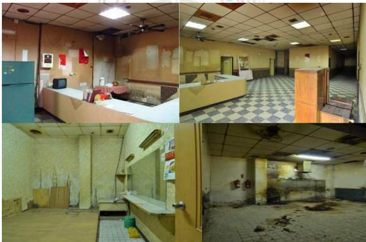
圖 2-3 修復前的萬國戲院茶室一樓空間
