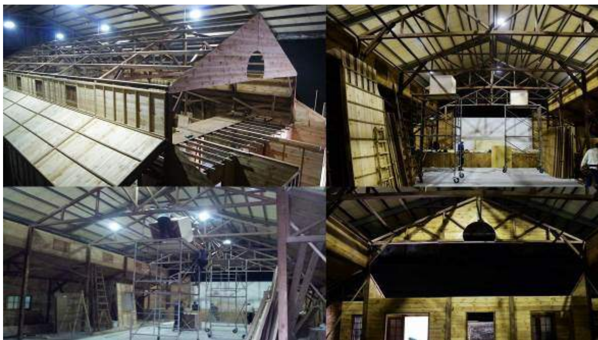
圖 4-6 民視搭設戲院場景施工過程-2 資料來源 本研究拍攝
