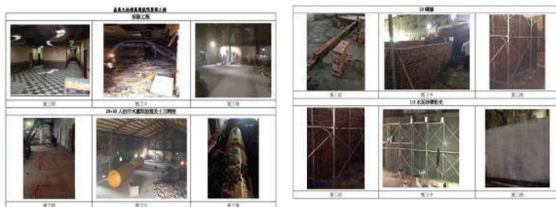
圖 3-11 萬國戲院茶室空間拆除與泥做工程
