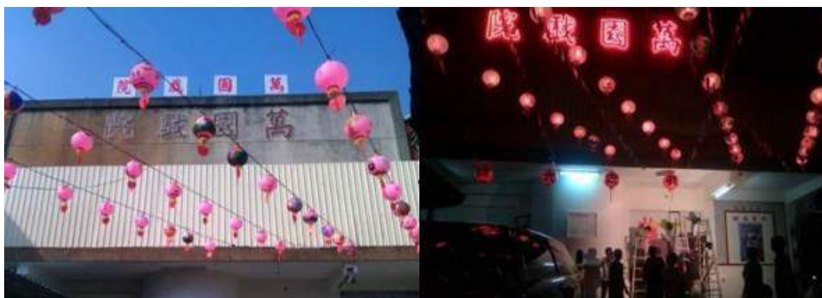
圖 2-12 萬國戲院二樓看板工程修復
