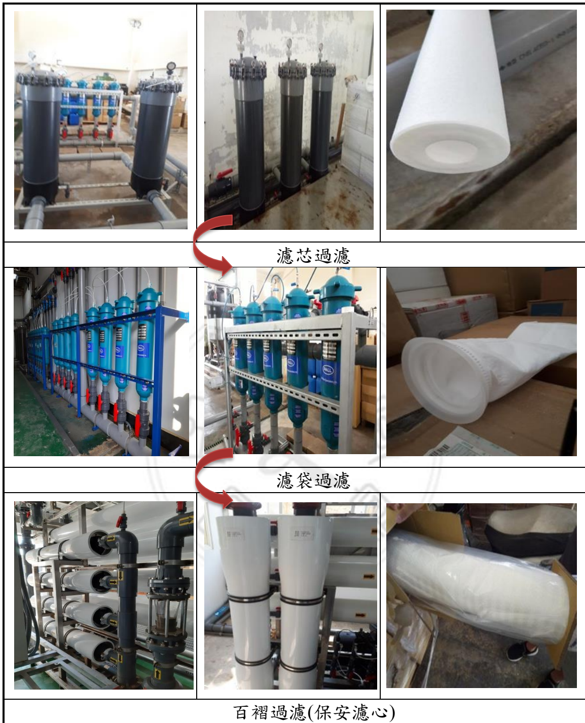
圖 3.14 馬祖南竿二期、北竿、東引、西莒海淡廠之 濾芯、濾袋及百褶過濾單元
