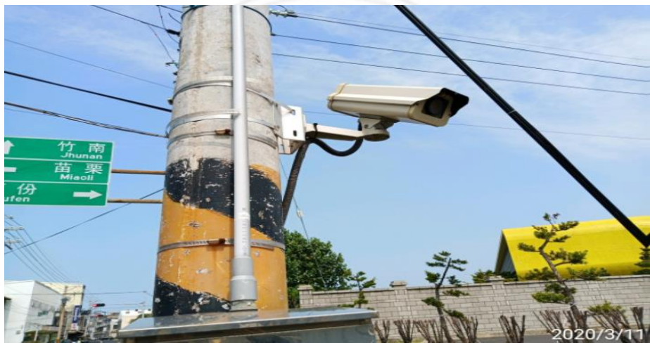
圖 4.5 水質自動監測視設備
