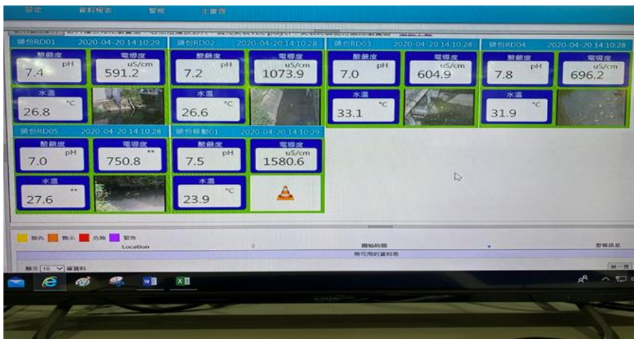
圖 4.6 水質自動監測視設備顯示器
