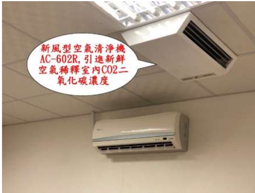
圖 4-6 QQair 新風型空氣清淨機 AC-602R 新鮮空氣引進
