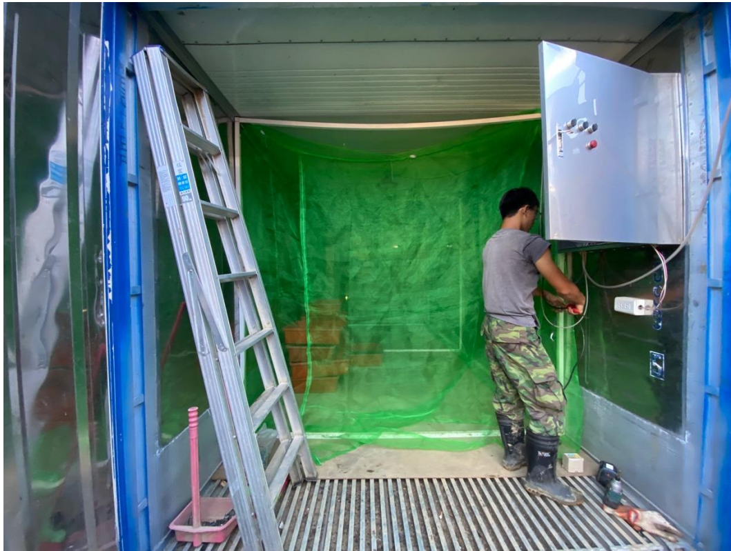
圖 15 環境控制與數據收集電控盤建置
