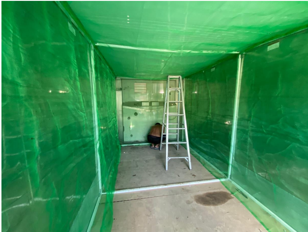
圖 13 貨櫃繁殖區防蟲網架設
