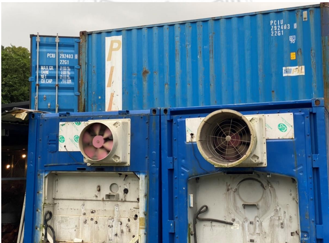
圖 18 保溫貨櫃建置可調節溫濕度裝置
