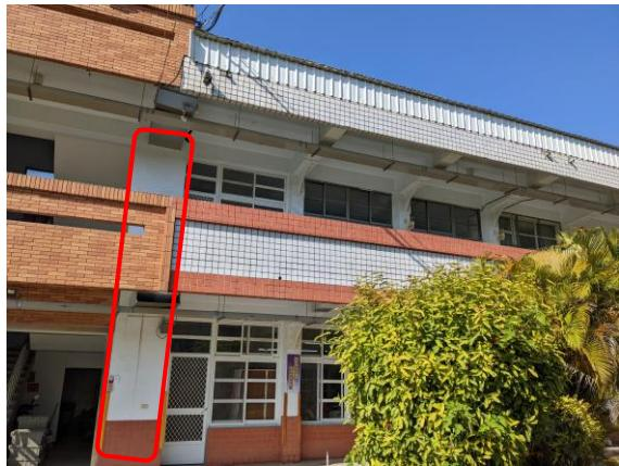
圖 4-2 國小校舍地震後兩側結構補強-擴柱(紅框處)
