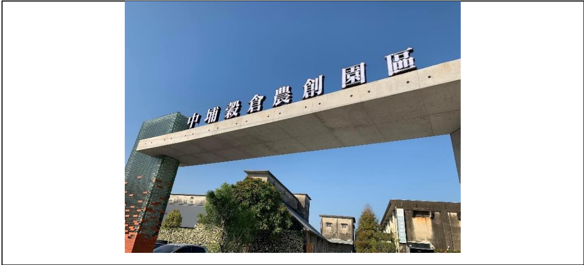
圖 4.11 中埔穀倉農創園區大門採以清水模方式建築，與舊有建築物外觀搭配起來比較沒有違和感。
