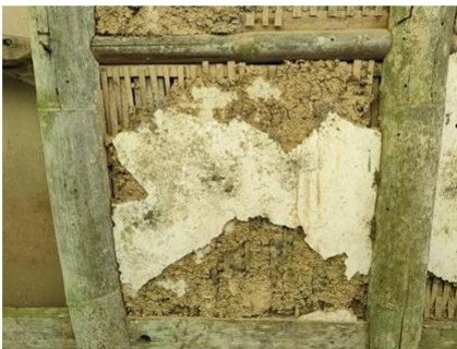
原始的竹編夾泥牆，可看見傳統的材料組成
