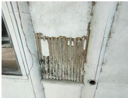
從新整修後的泥牆以水泥取代泥土
