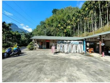
右護龍因漏水翻修成鐵皮屋頂
