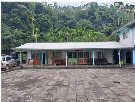
木造右護龍屋頂以翻新
