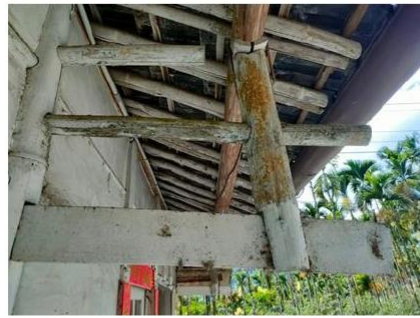
左護龍廊道下的懸臂樑支撐
