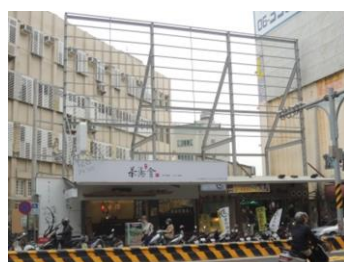
圖 4-3-49、位於中山路東南側建築物頂部的支架構造(二)(圖片來源：本研究拍攝)
