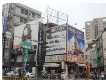
圖 4-3-48、位於中山路東南側建築物頂部的支架構造(一)(圖片來源：本研究拍攝)
