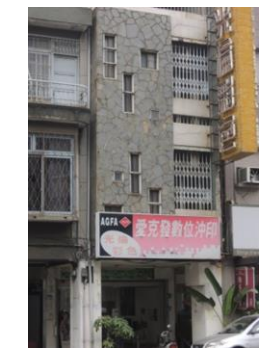
圖 4-3-30、中山路西北側上的建築立面表現是對原建築物立面的再設計(圖片來源：本研究拍攝)
