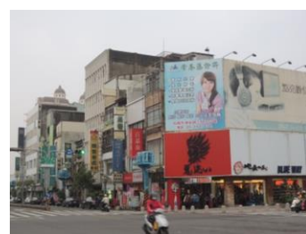
圖 4-3-50、位於中正路西北側建築物立面上的支架構造(圖片來源：本研究拍攝)
