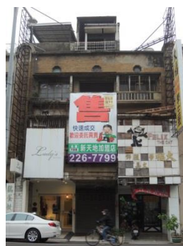
圖 4-3-47、位於中正路東南側建築物立面兩側的支架構造(圖片來源：本研究拍攝)
