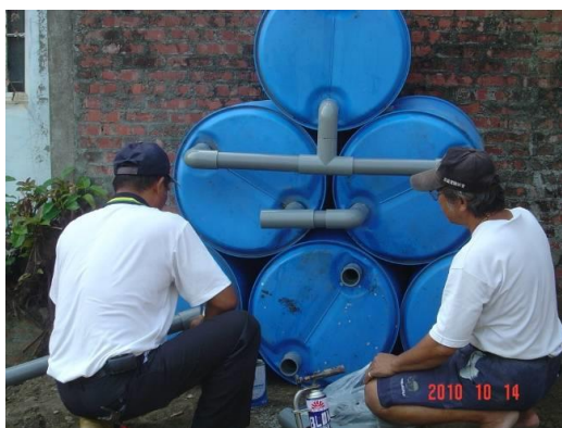
圖 4-19: 裝設中水回收設備情形
