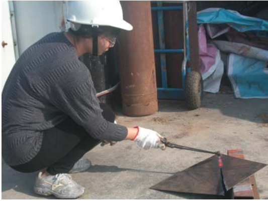
圖 3-5 氧乙炔切割 (圖片來源：筆者操作圖)
