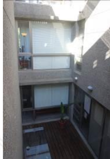
中庭布置二樓俯瞰的角度
