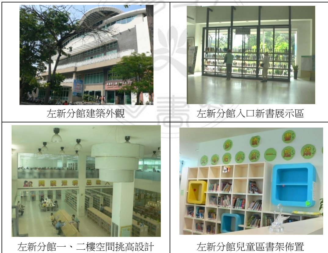
圖 3-1-8：高雄市立圖書館左新分館建築外觀與室內空間照片
