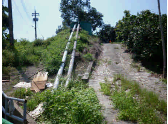
圖2.27 抽水站出水管
