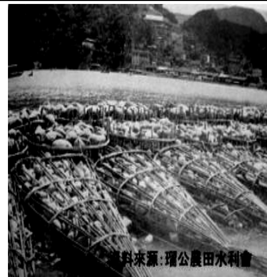
圖 3- 26 新店溪瑠公圳石筴堰堤
