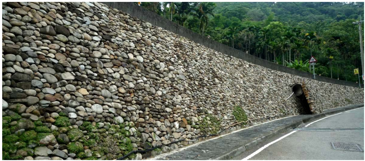
圖 4- 45 南投車埕路旁的擋土牆採水泥卵石砌
