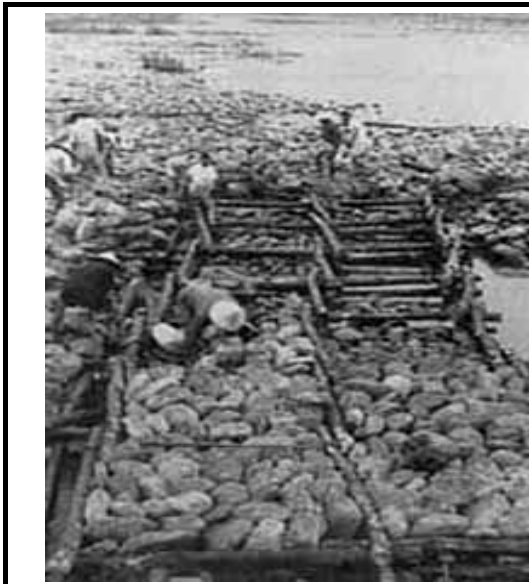
圖 3- 23 工人用松柏製作木工沉床，再以石塊填平
