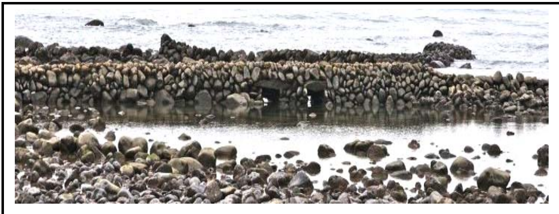
圖 3- 53 六塊厝藍仔石滬進出水口
