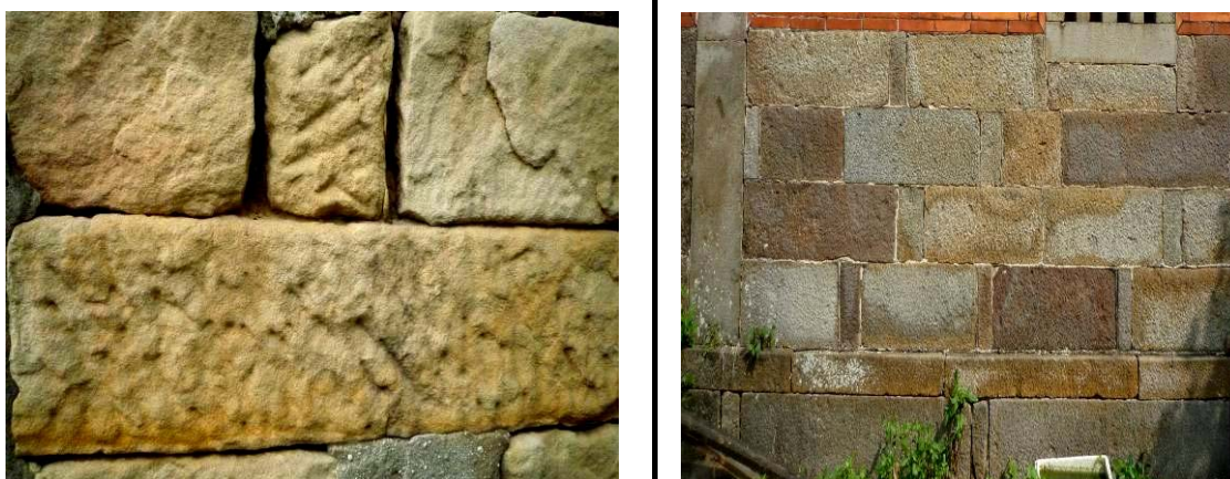
圖 4-37 平砌牆面有粗琢、細琢的痕跡 2010.01.30，淡水忠寮，拍攝者:孫家珍
