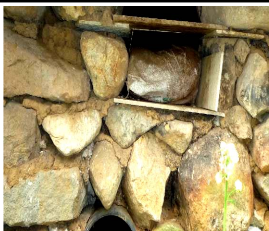
圖 4- 63 北部石造民居填縫土
