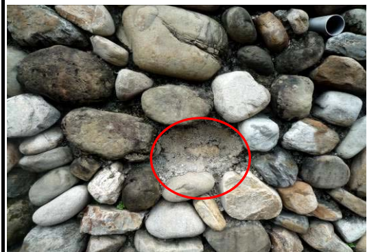
圖 4- 47 中間卵石已脫落 拍攝者:孫家珍，2011.07.10，南投車埕
