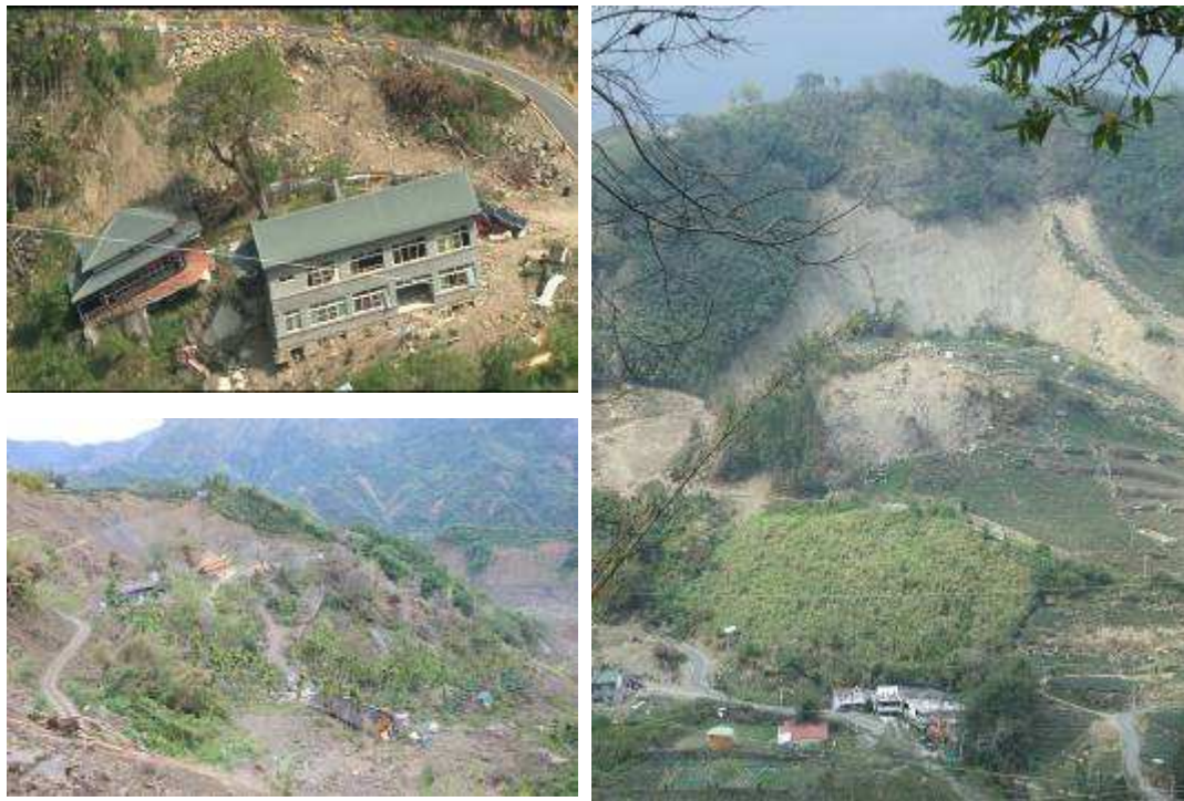
圖 3-19 莫拉克風災後之太和，圖片來源：許誠賢先生提供(災後相片：左圖為太和村油車寮地區走山情形、右圖上為油車寮之清心茗茶產銷班毀損、右圖下為太和村公田地區走山景象)
