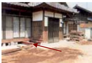
圖 4-36 ④H 型鋼設置
