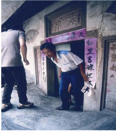
圖 3-6 林邊鄉房屋下陷 1.5 米
