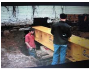
圖4-58 穿入46” 縱向工 資料來源: WOIF MOVER網站 2011
