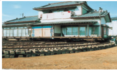
圖 50 故宮願景館輕量工字軌遷移示
