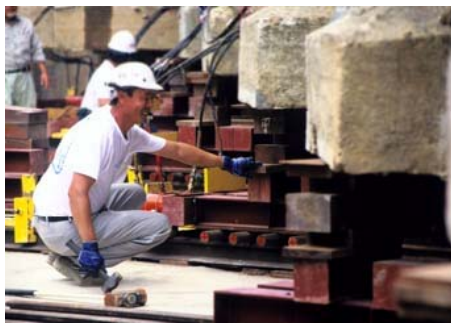
圖4-54柱與腳樁、地樑分離工程
