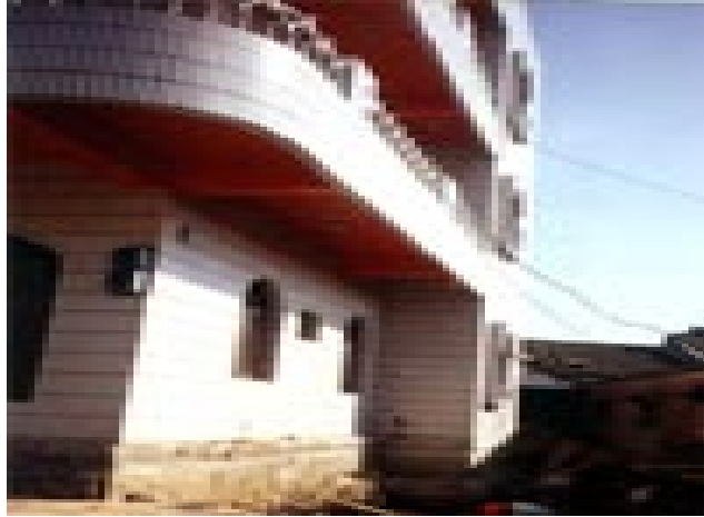
圖 3-4 雲林虎尾鎮：三層樓別墅 50 坪 89 年因 土地分割轉向遷移 5 公尺。 資料來源:建興樓房遷移工程行照片(1990)
