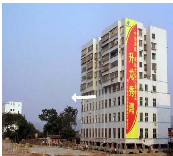
圖2-19廣西梧州市人事局綜合大樓 平移示意圖
