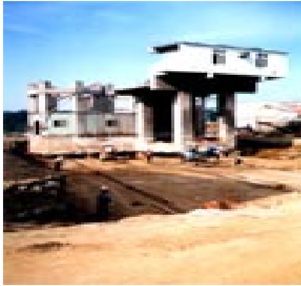
圖 3- 3 苗栗後龍鎮錦鋒混凝土公司 道路拓寬遷移 40 公尺。 資料來源: 建興樓房遷移工程行照片(1996)
