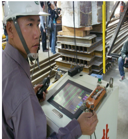
圖2-8 第四期(2001s-) 電腦油壓自 動化控制與感應系統 資料來源：南北樓房遷移工程行照片(2010)
