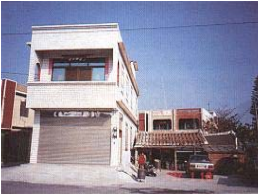
圖 1-1 西南沿海地區房屋高低差異 (資料來源:經濟部水利署 2000 年)
