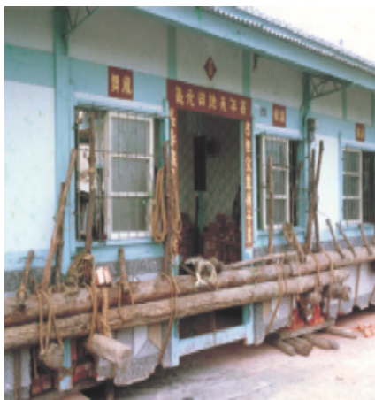
圖 2-3 三合院遷移工程(1975) 圖 2-4 年嘉興宮遷移工程(2007)
