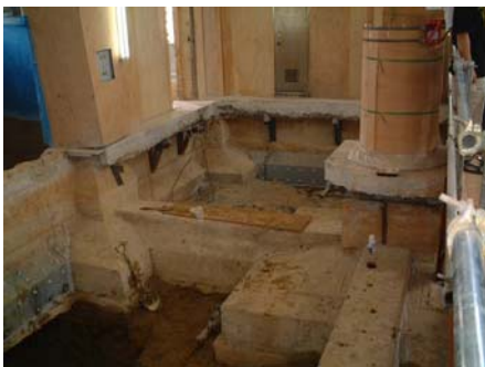
圖4-52基礎結構與基地周邊開挖
