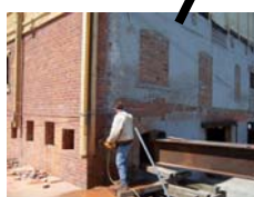
圖4-67開鑿工字鐵井孔
