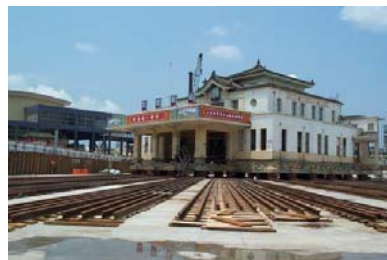
圖4-56 牽引、拉動與定位遷移工程
