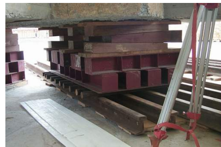
圖4-55柱底裝置鐵棒輪、鋪置軌道
