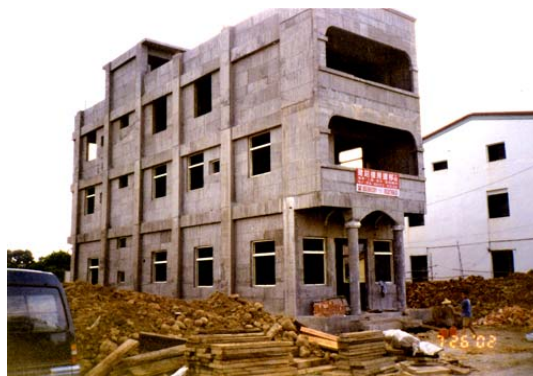
圖 3-5 花蓮市土地糾紛 3 樓 100 坪 左遷 5 公尺。 資料來源:建銘樓房遷移工程行照片(2002)
