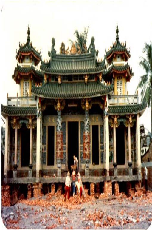
圖 3-13 屏東廟宇昇高 資料來源: 建銘樓房遷移工程行照片 (1998)
