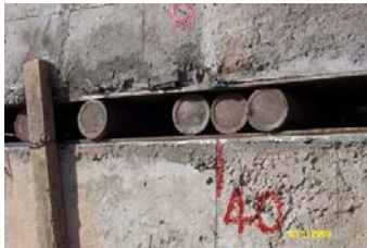
圖4-74 建築物在上軌道、下軌道移動 （夾層分別為鉄板、滾筒、鉄板） 資料來源：新華網 2002
