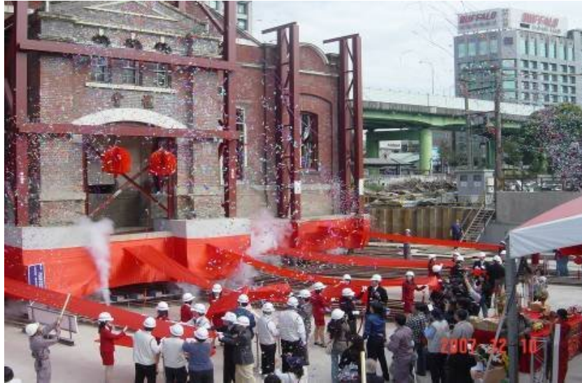
圖 3-11 96.12 臺北工場挪移開工儀式 資料來源: 南北樓房遷移公司照片(2007)
