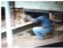
圖4-59 穿入46” 縱向工字鐵 資料來源: WOIF MOVER網站 2011
