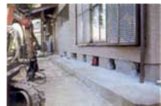
圖 4-35 ③開鑿 H 型鋼槽井
