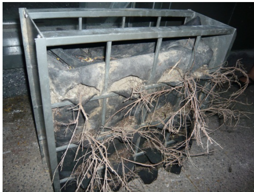
圖 4-2-4 新光三越左營店(植栽枯死汰換)
