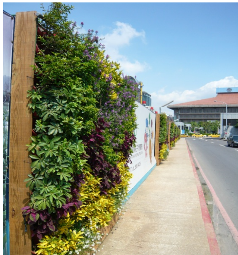
圖 4-1-5 台北車站旁機場捷運施工圍籬
