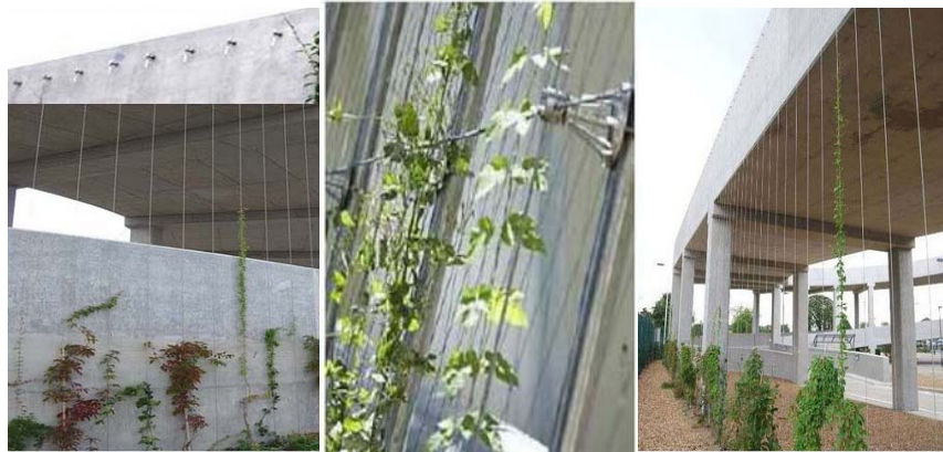
圖 2-1-1 『不鏽鋼纜索系統』開始被應用於建築物壁面綠化。
