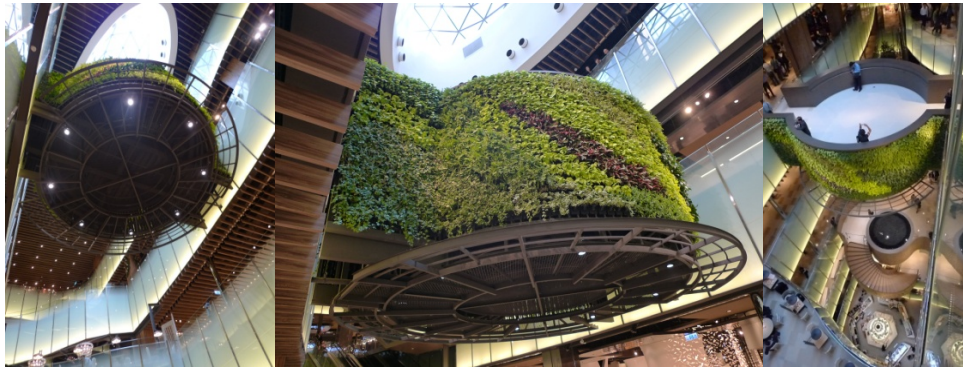
圖 2-1-24 台北京站百貨，立體懸空走廊面材採用植綠生牆。
