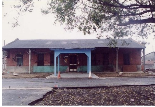
圖 3-6-1 課餘軒整修前樣貌
