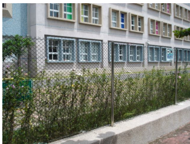
圖 2-3-22 志航國小正門左側圍牆
