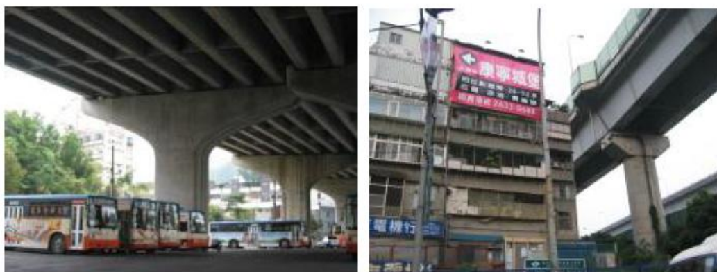
圖 6、高架道路下的失落空間
