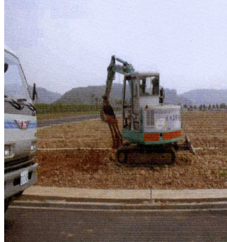
圖 4-2-177 怪手挖土整地
