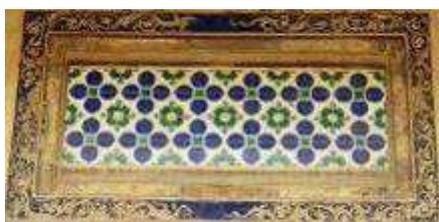
圖片說明：以工業化大量生產的彩磁裝飾門額及水車堵及檻牆部份，以顏色豔麗、施工方便取代了傳統建築中的石雕、磚雕及泥塑。
