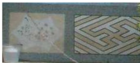
圖片說明：簡宅以平面洗石子幾何圖案裝飾外牆。
