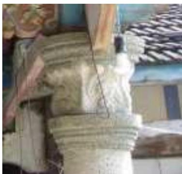
圖片說明：簡宅以洗石子柱取代傳統建築石柱，受西洋建築柱式的影響，呈現融合多立克柱頭圓形盤狀體及柯林斯莨苳植物柱式的特色。莨苳植物類似台灣的白菜植物，因此匠師直接仿白菜樣式製作。
