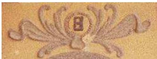
圖片說明：以西洋建築手法裝飾建築外牆，以模壓製東洋菊花圖騰裝飾。融合東西文化風格。
