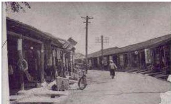
圖說：1904A.D.大林街道建設以雁齒磚砌築成水溝，街路面闊有3間半，左右各有1丈寬的亭仔腳步道。圖片來源：《大林風情之映像》。
