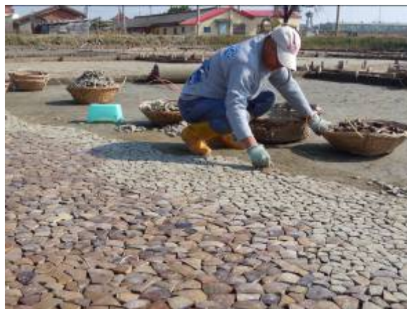
圖 4.3 布袋洲南文化鹽田，以原物料、原工法的方式進行鹽田整建，如本圖老鹽工以人工翻修結晶池，彎著腰蹲在地上將酒甕碎片一片片做拼貼。
