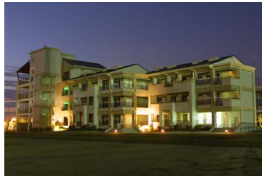
圖 4-22 北棟教學大樓
