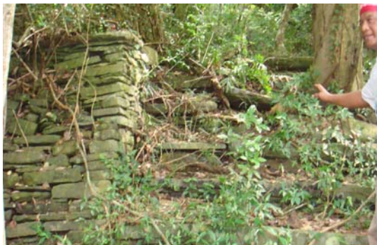
圖 2-91 及 2-92：聚落裡的駁坎及石階，駁坎的工法歷經百年仍緊實無缺。
