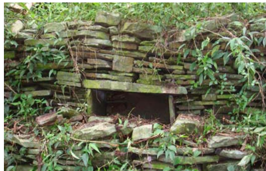
圖 2-88：RU 部族大祭司屋靈龕位於後室正後方，寬約 1 尺、深約七、八吋
