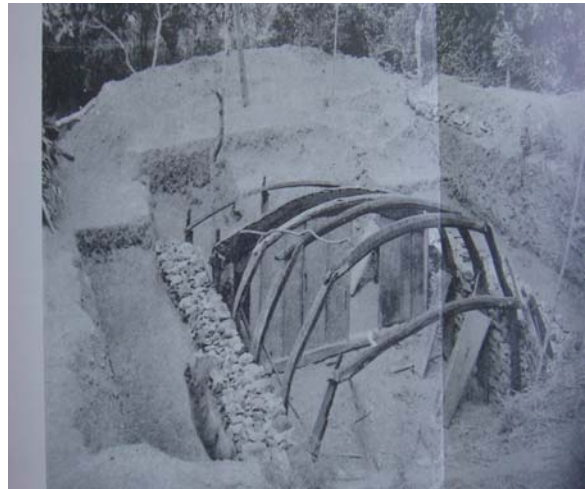
圖 2-3：先掘下地基，在周圍積石為壁 圖 2-4：立柱架橫樑
