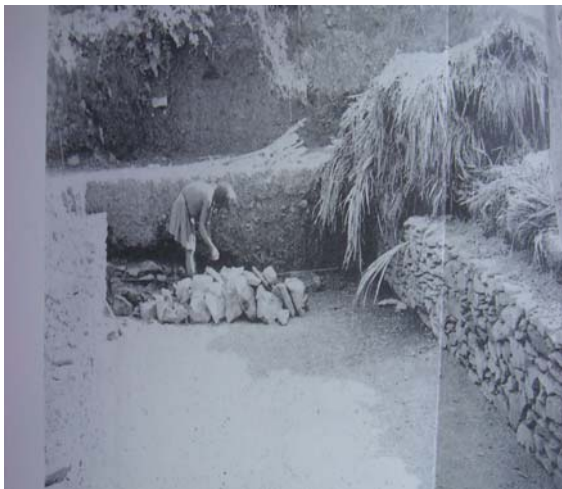
圖 2-3：先掘下地基，在周圍積石為壁 圖 2-4：立柱架橫樑
