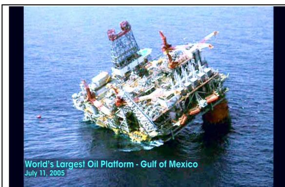
圖表 223 遭到颶風毀壞的閃電馬鑽油平台。
