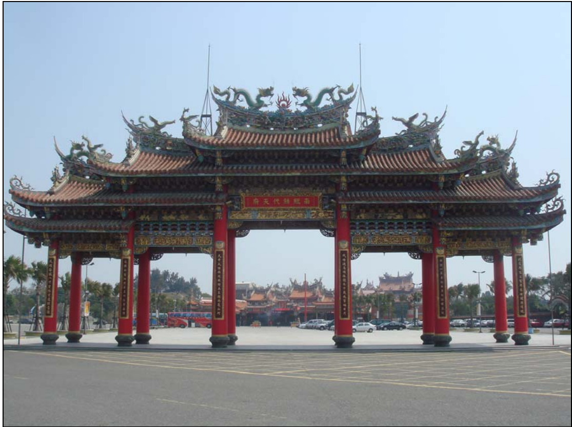
北門南鯤鯓大牌樓（大木構）
