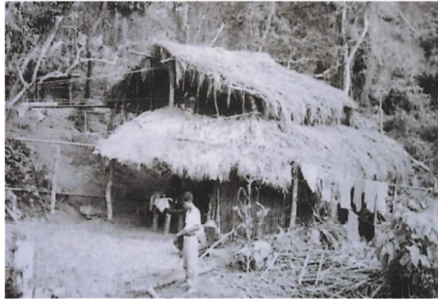
【圖3-09】腦寮蓋以雙斜面的茅草為頂，無實體之牆面、通風良好(苗栗縣文化局網站)
