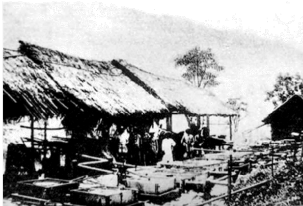
【圖4 - 03】「土佐式」冷卻箱與結晶箱 (蘇澳鎮公所網站)
