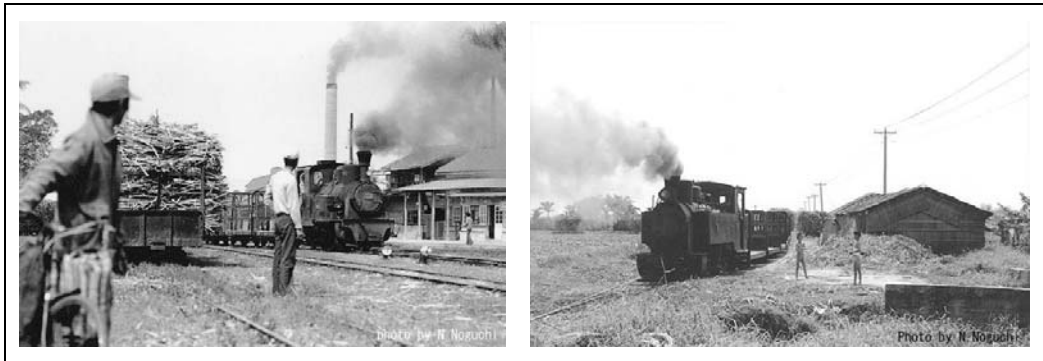
【圖 2-23】蒜頭糖廠製糖時期，旁邊堆滿著甘蔗準備壓榨，其蒸汽火車來來往往地前往原料區載甘蔗(野口信夫先生的台灣糖業鐵路網站 50 ，1977)
