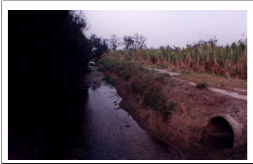
鰲鼓蒜頭糖廠的防風林、灌溉水渠及產業道路規劃良好
