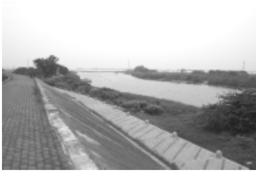
圖 4-1-1 朴子溪堤岸風貌
