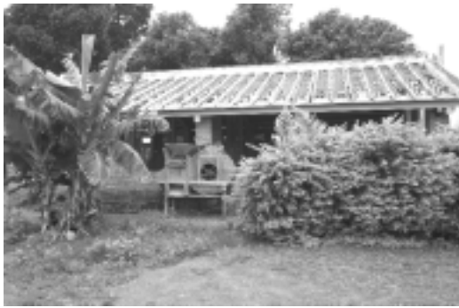
圖 4-3-11 老舊房舍有待整理
