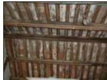
圖 2-18 竹管結構屋頂實景
