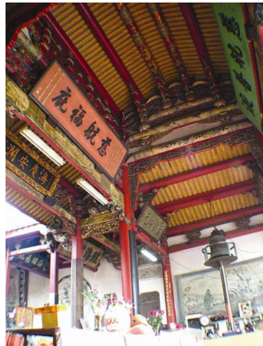
圖 2-2-10 拜殿高大壯闊的捲棚式木構屋架 資料來源：本研究自攝。
