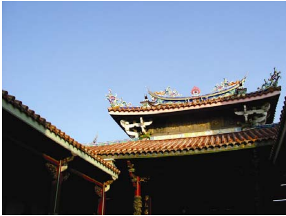
圖 2-2-9 拜殿屋頂為等級較高的歇山重簷式架構 資料來源：本研究自攝。
