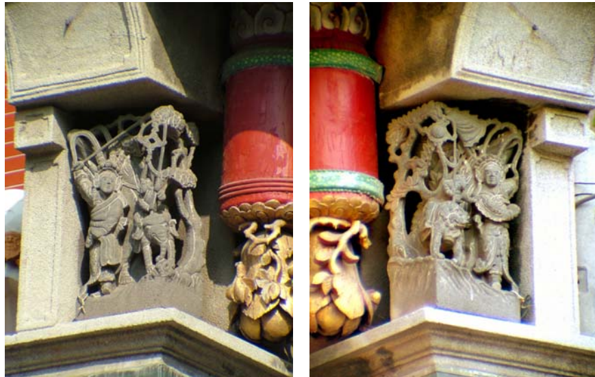
圖 4-2-2 三川殿，兩面山牆靠近屋簷口的部位有墀頭做裝飾性的收尾
