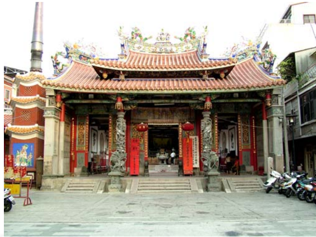
圖 2-2-14 三川門將原來硬山式的三川脊屋頂改建成現在假四垂頂。前檐原本的八角石柱改換成觀音山石的豪華龍柱。
