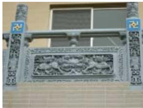
圖 5-3-6 預製水泥欄杆上漆(南陽聖堂修道院)
