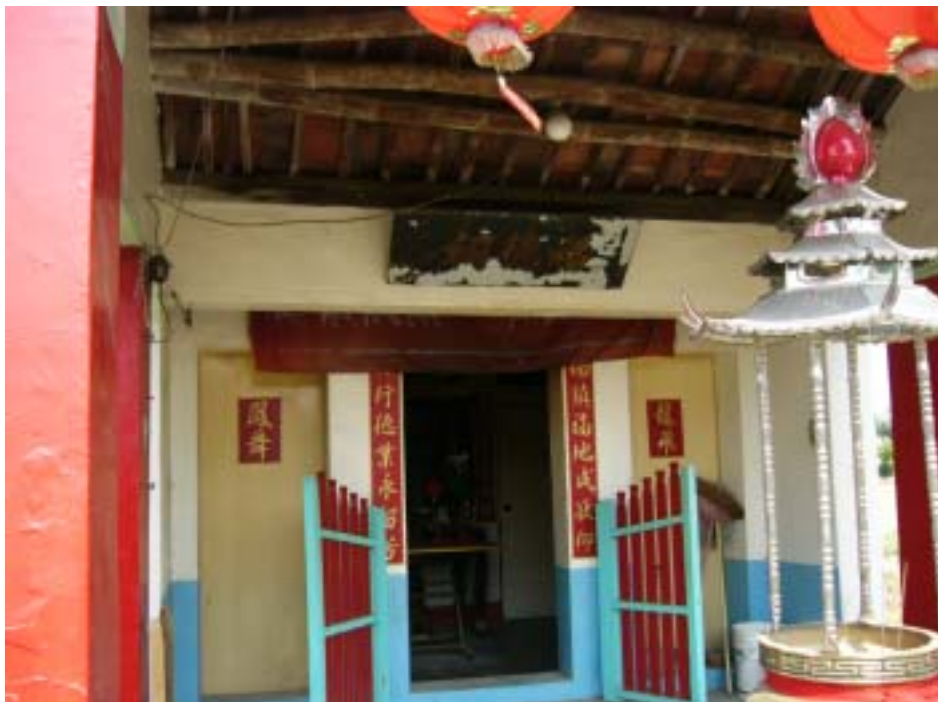
福德祠的拜殿現況可清楚看出屋頂構造方式
