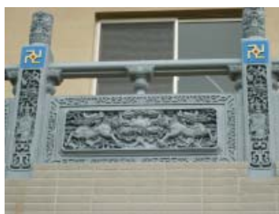
塗裝完成的預製欄杆
