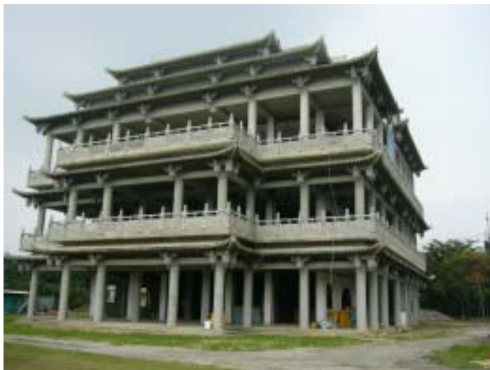
結構體初完成的主殿外觀
