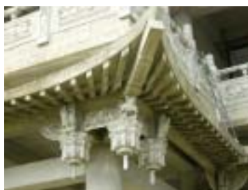
圖 5-3-13 南陽聖堂修道院吊籃及出檐 圖 5-3-14 雀替圖 5-3-15 八卦藻井(後協里代天府)
