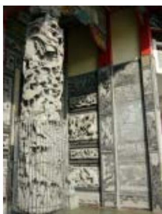
圖 5-2-3 三奶宮觀音山石浮雕 並有風化現象
