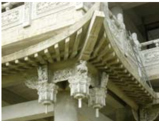
剛完成吊裝的預製吊籃及插角
