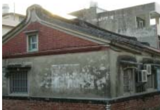
圖 5-1-2：清水磚與砂漿粉刷交錯表現的方式
