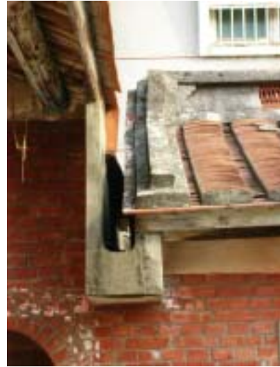
混凝土施作的天溝
