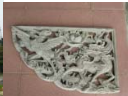
泥漿灌注的預製裝飾構件-插角
