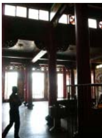
「中庭」變爲較低矮的空間產生高窗兼具採光通風之效
