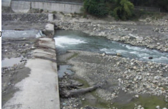
照片 5-3 烏溪支流北港溪大旗堰(重力式) (本研究拍攝)
