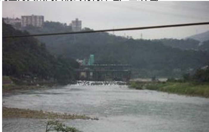
照片 5-21 新店溪青潭堰堰下游（本研究拍攝）
