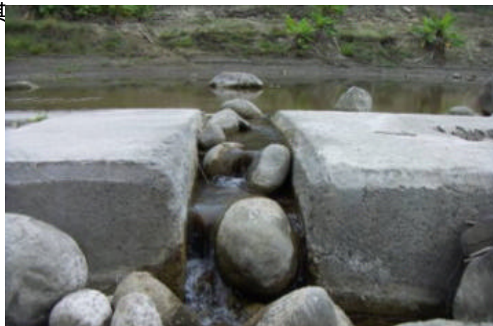
照片 5-53 八掌溪 NO.4 固床工可供魚洄游現況(本研究拍攝)
