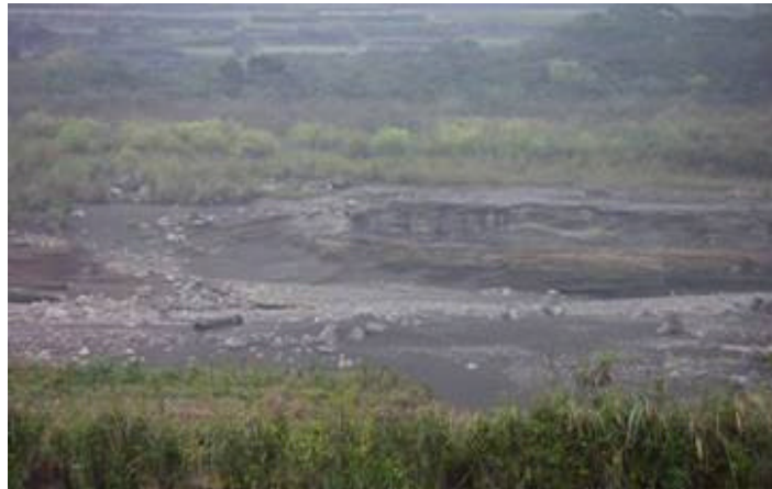
照片 5-7 頭前溪隆恩堰下游刷深現況（本研究拍攝）
