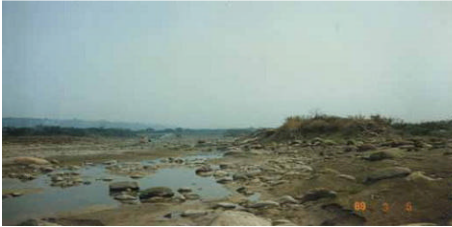
照片 5-31 民國 78 八掌溪仁義潭攔河堰下游（水利署第五河川局）
