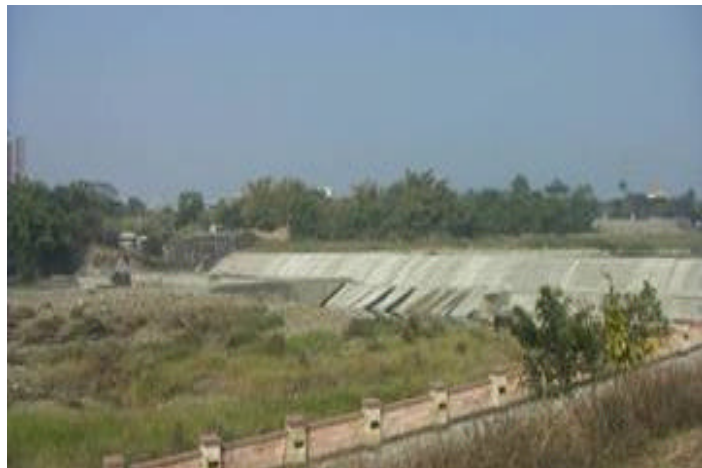
照片 5-15 道將圳攔河堰正面（本研究拍攝）
