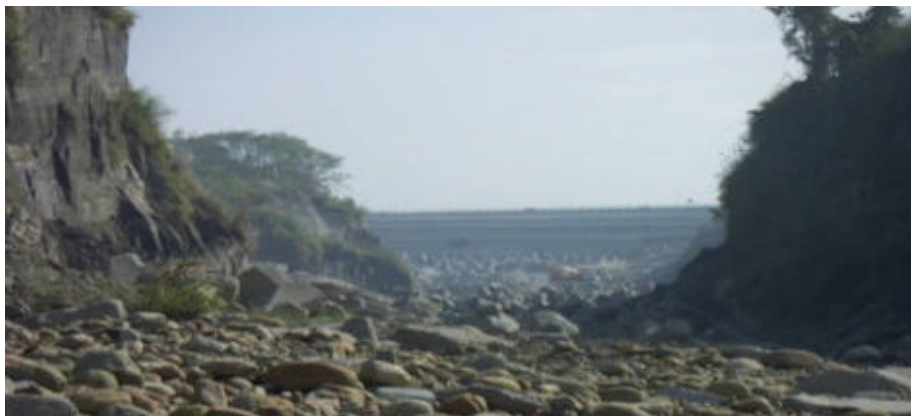
照片 5-32 仁義潭攔河堰現況（本研究拍攝）
