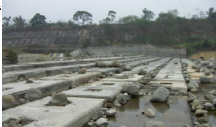
照片 5-54 八掌溪 NO.4 固床工 (本研究拍攝)
