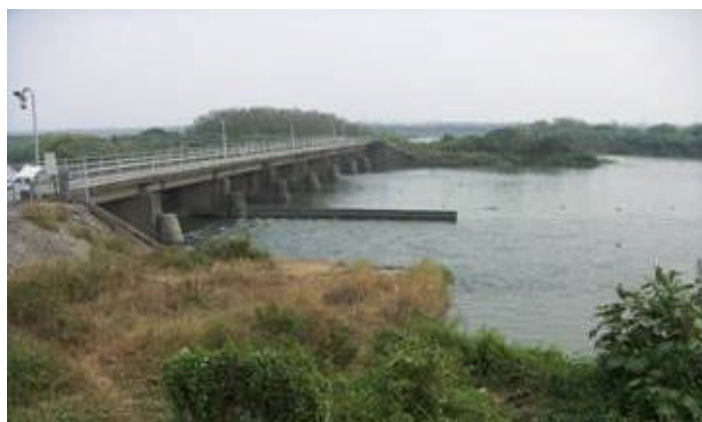
照片 5-19 東港溪攔河堰下游 (本研究拍攝)
