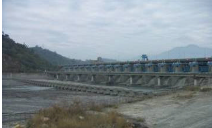
照片 5-17 濁水溪集集攔河堰(閘門機械式) (本研究拍攝)
