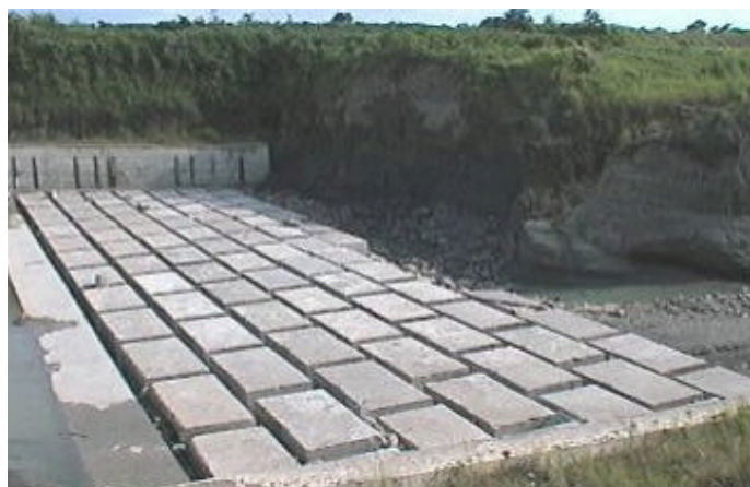
照片 5-38 八掌溪 NO.17 固床工側面
