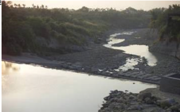
照片 5-35 八掌溪五虎寮橋固床工現況(本研究拍攝)
