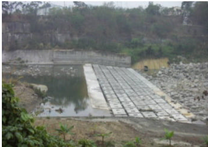
照片 5-49 八掌溪 NO.4 固床工側面 (本研究拍攝)
