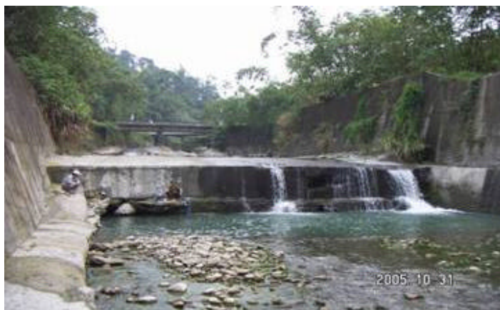
照片 5-36 三疊溪大林堤段固床工現況(本研究拍攝)
