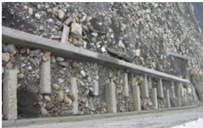
照片 5-5 烏溪支流北港溪大旗堰魚梯 (本研究拍攝)
