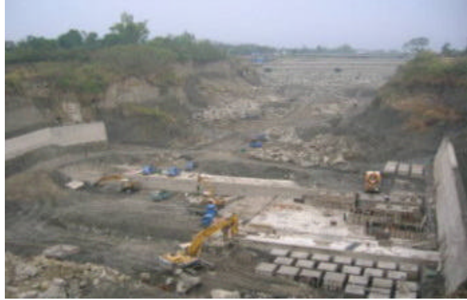
照片 5-41 施工中八掌溪 NO.17 固床工施工現況 (本研究拍攝)
