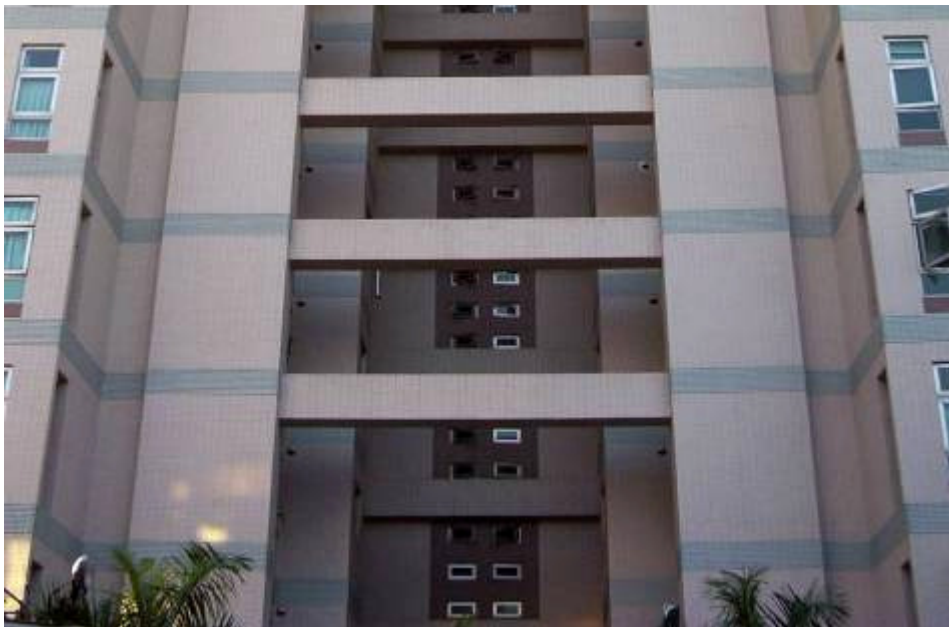
相片 4-17 集合式住宅結構因素導致日照不足現象 本研究攝影
