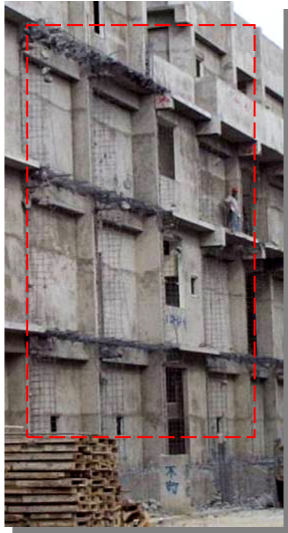
相片 4-4 增建部分搭接鋼筋 本研究攝影
