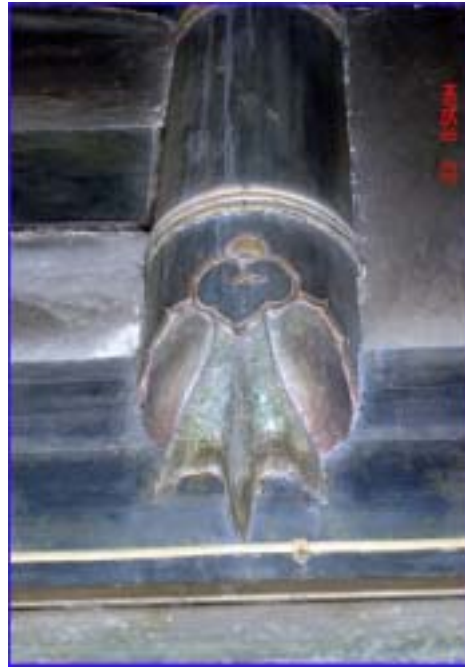
圖 3-24 棟架上方採瓜桶設計
