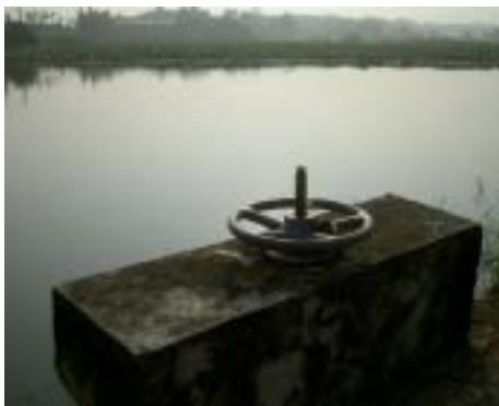
圖 3-43 蓮花埤大閘門 資料來源：本研究拍攝
