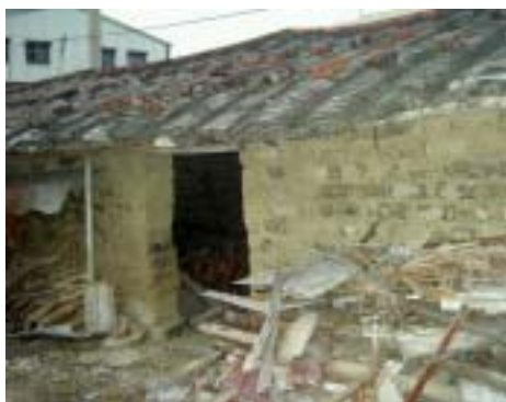
圖 3—5 「檳榔園」現今內角四十二號 魏家第一落之公廳建築以及土埆厝遺址 資料來源：本研究拍攝
