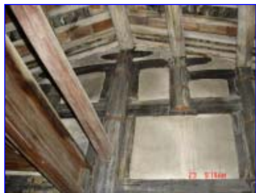
圖 3-26 大廳的樑柱結構
