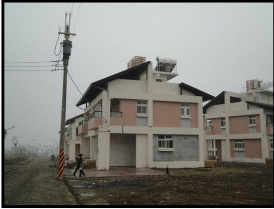
(圖 29)五里埔重建區永久屋 69
