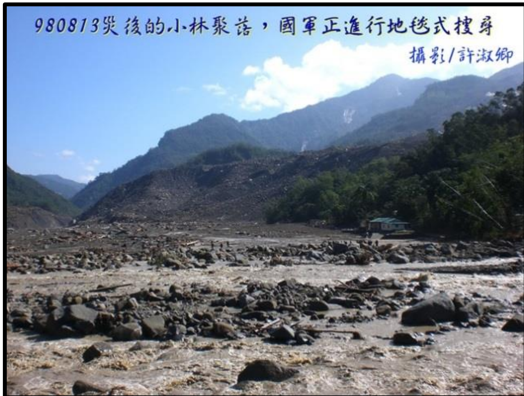
(圖 25)小林災區(9 - 18 鄰原址) 51
