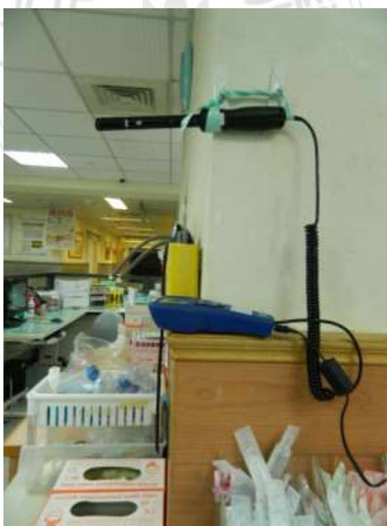
圖 3.2-4 室內環境物理測量之儀器放置—急診診間區
