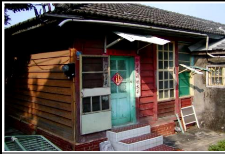
圖 17 鳳山新村的雨淋板造建築
