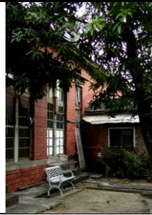
圖 18 鳳山新村的磚造建築
