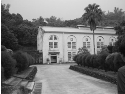
圖 2 竹仔門電廠發電廠房。
