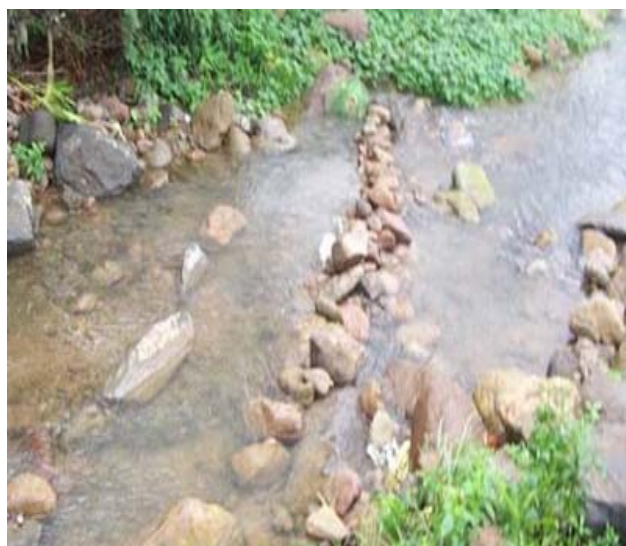
圖三 石梁困床工
