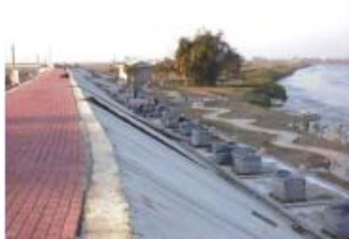
圖 1-4 下游河堤與淤灘生態工程整治
